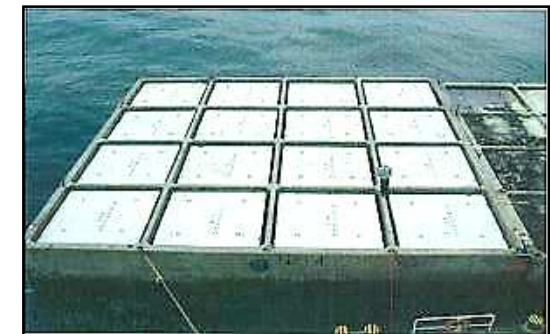
⑫ コンクリート蓋据付完了
