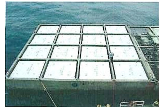
⑫ コンクリート蓋据付完了
