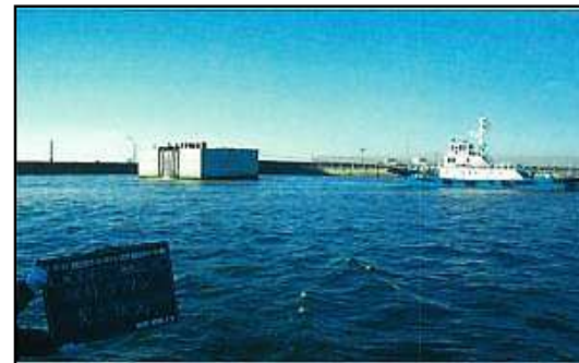
⑥ ケーソン牽引
