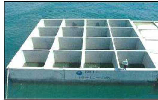
⑦ ケーソン設置
