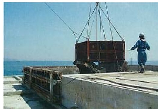
⑮ 防波堤据付
