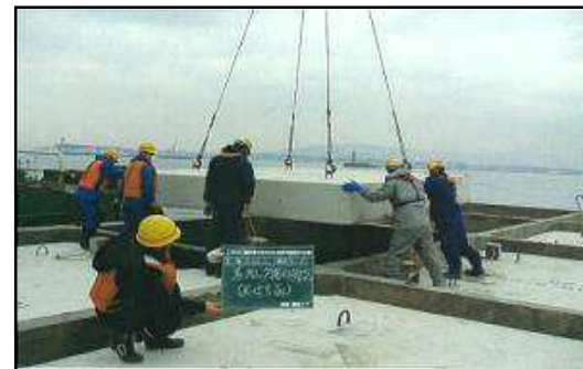
⑪ コンクリート蓋据付
