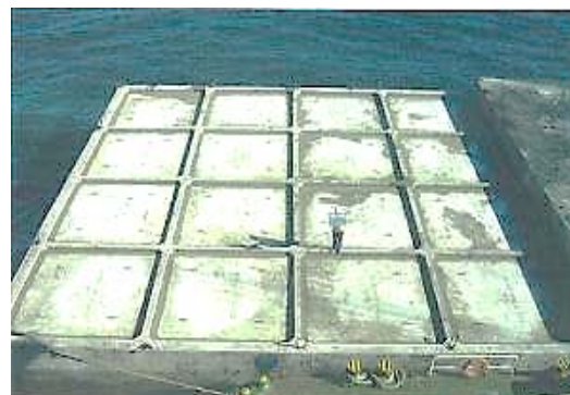
⑭ コンクリート充填完了
