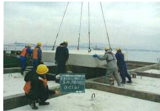
⑪ コンクリート蓋据付
