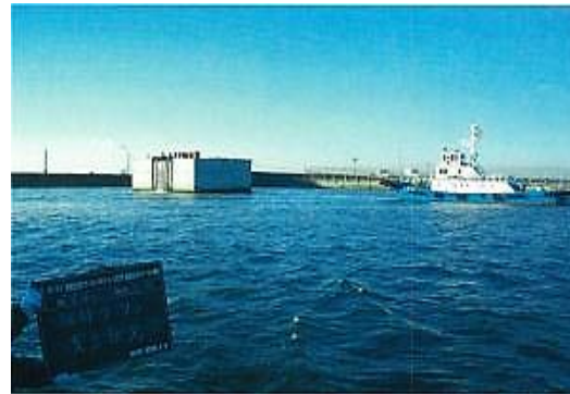
⑥ ケーソン牽引
