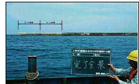
⑯ 防波堤据付完了
