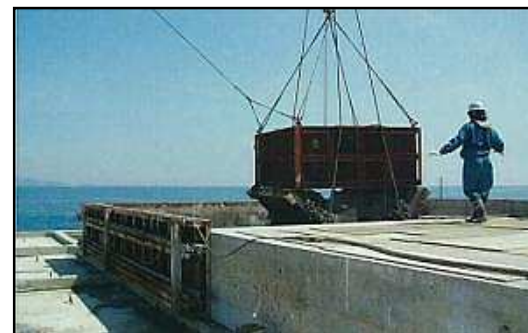
⑮ 防波堤据付
