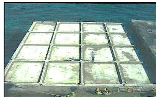
⑭ コンクリート充填完了
