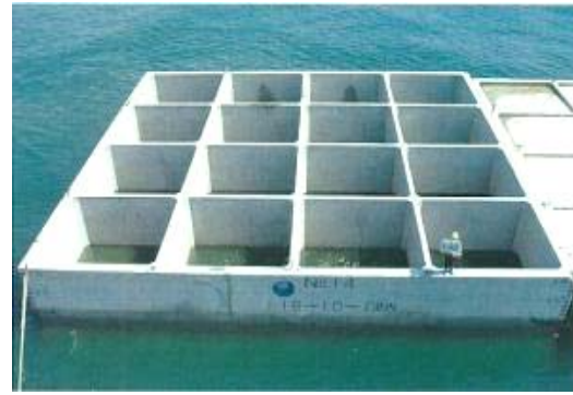
⑦ ケーソン設置
