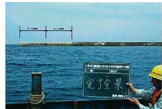
⑯ 防波堤据付完了
